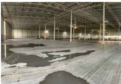
Gjutning av golv - 40 betongbilar / dag under 6 veckor kommer att rulla in till bygget
