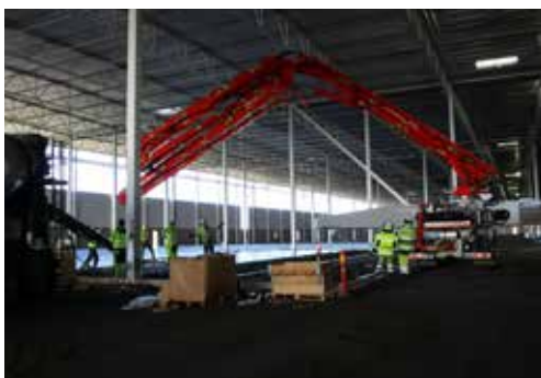
Gjutning av golv - 40 betongbilar / dag under 6 veckor kommer att rulla in till bygget
