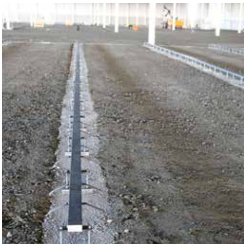
6 km räls kommer att monteras
